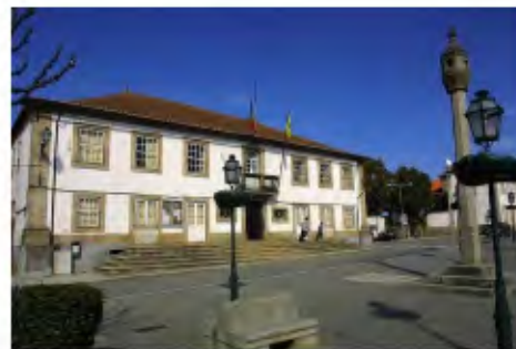
Figura 107 | Antigo Edifício dos Paços do Concelho
