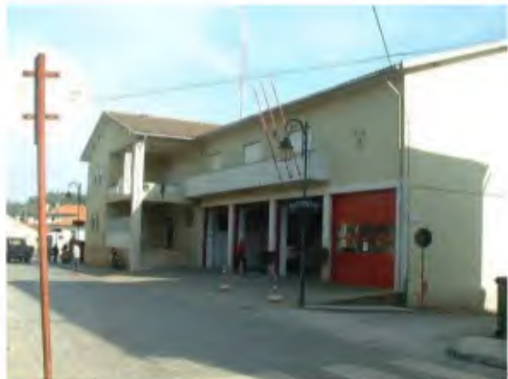
Figura 63 | Quartel dos Bombeiros, em Penalva do Castelo
