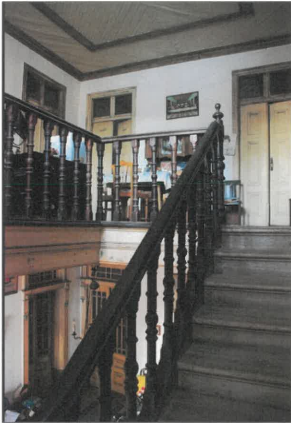
Figura 18. Escadas de acesso ao 2.º piso.
