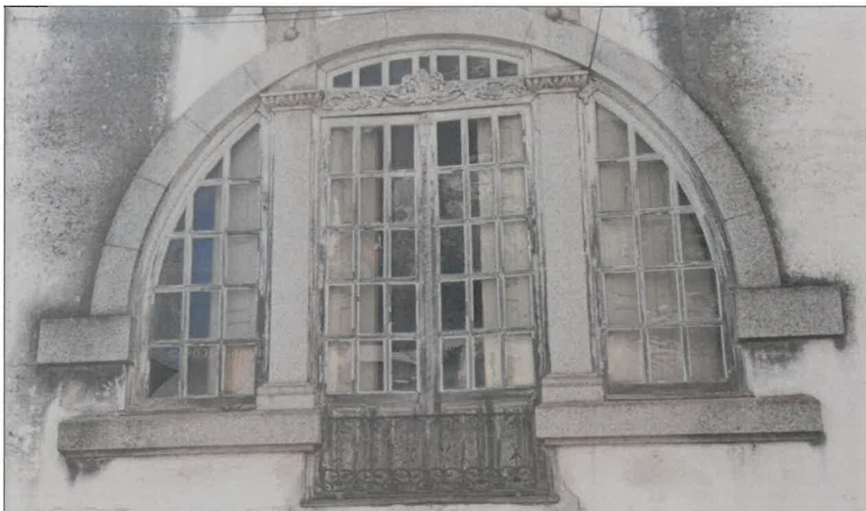
Figura 11. Janela – fachada principal.
